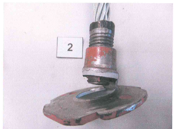
c: Bruch des Einschlagankers
