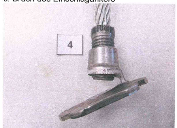
e: Bruch des Einschlagankers
